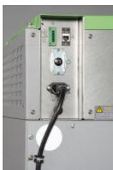
A ligação à energia elétrica de CA está situada na parte de trás do congelador, no painel elétrico encastrado. Certifique-se de que o interruptor de alimentação está em OFF (Desligado) antes de instalar ou de retirar o cabo de alimentação.
